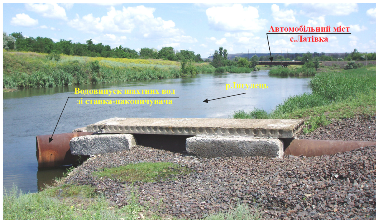
Рип. 1.5 Водовипуск шахтних вод з ставка-накопичувача.
