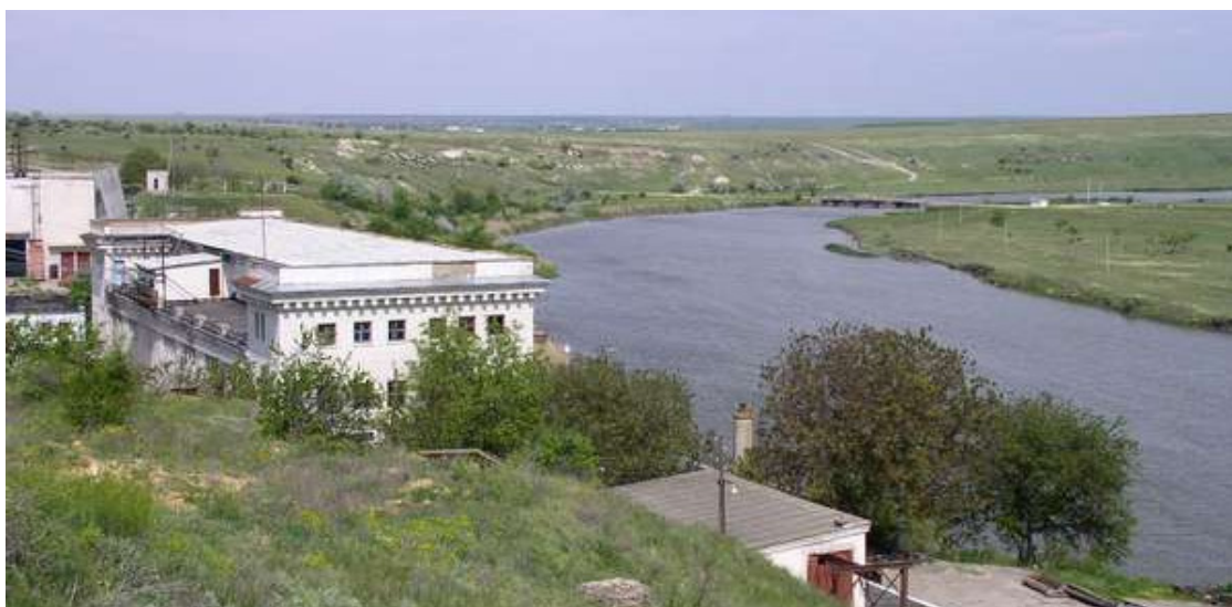
Рис. 5.69 Будівля насосної станції Інгулецької зрошувальної системи
