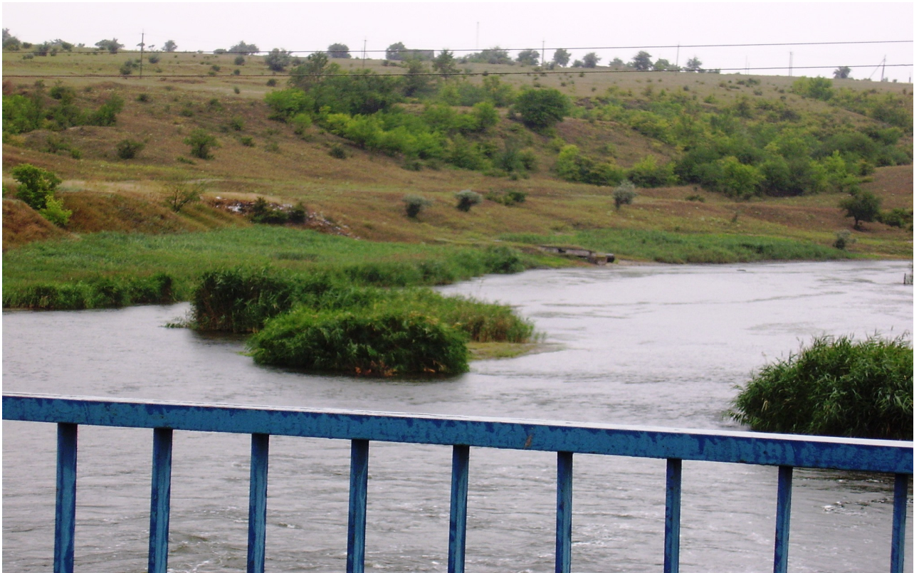
Рис. 1.6 Вид на водовипуск з автомобільного моста
