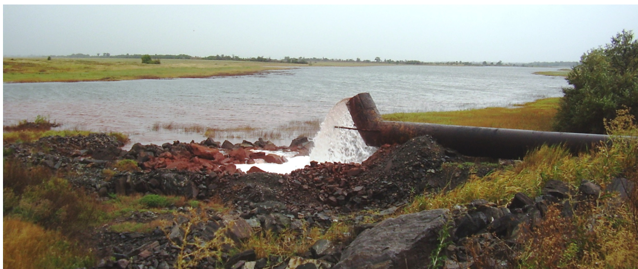
Рис. 1.3 Оголовок напірного трубопроводу
