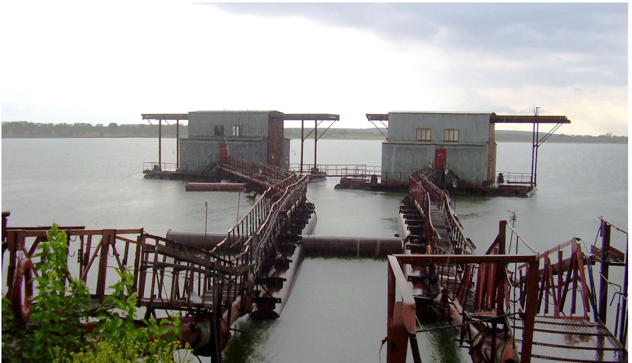
Рис. 1.7 Плавучі насосні станції на акваторії ставка-накопичувача
